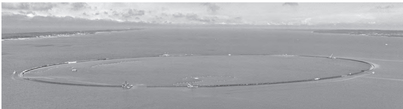
Zarys powstającej na Zalewie Wiślanym wyspy. Fot. NDI/Besix
