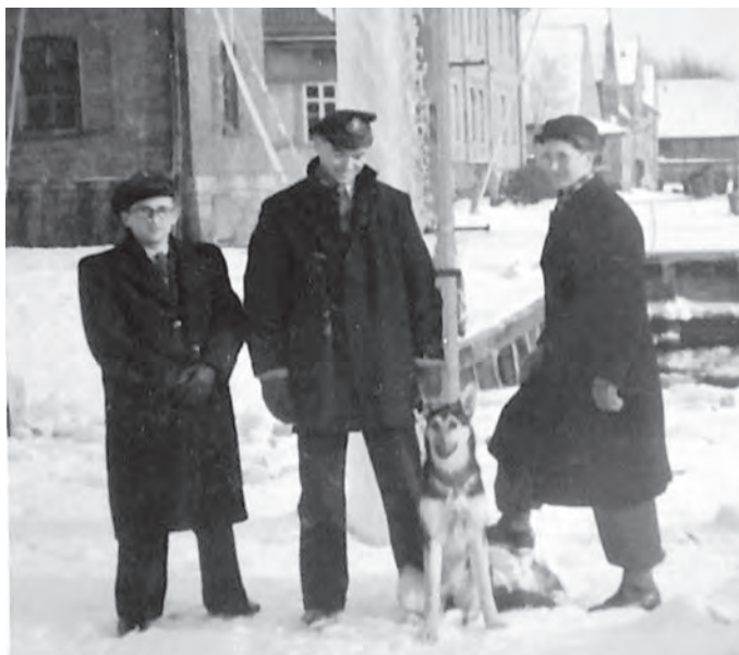
Z lewej strony Edward Zawadzki latarnik, w środku kapitana portu w Darłowie Józef Kaczanowicz na tle zimowej latarni morskiej. Połowa lat pięćdziesiątych. Źródło: ze zbiorów rodziny, udostępnione przez syna Jerzego Kaczanowicza. Fotokopia w zbiorach autora
