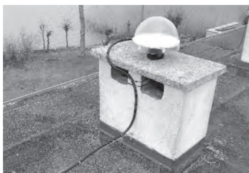
Fot. 1. Antena stacji referencyjnej RTK GNSS na kapitanacie we Fromborku
