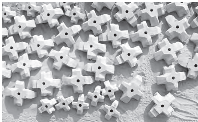
Jednostki Xbloc i XblocPlus. Na zdjęciu poniżej układanie pod wodą. Fot. NDI/Besix
