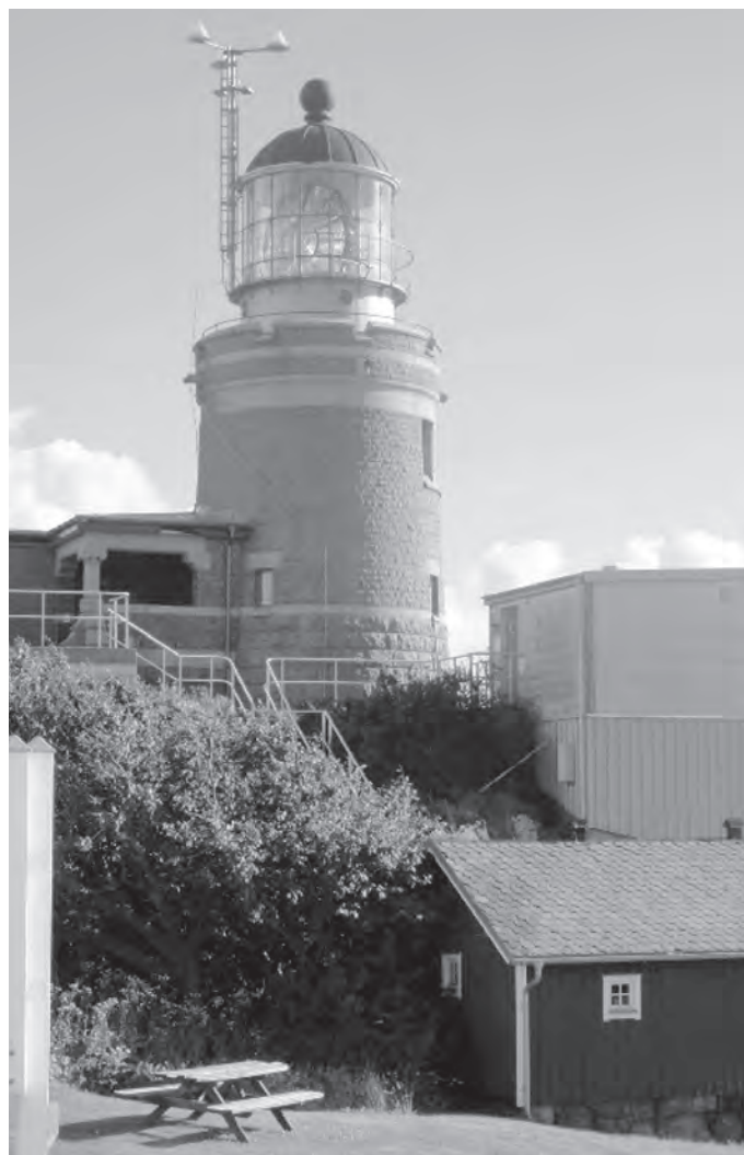
Ryc. 1. Widok na konstrukcję wieży Kullen. Fot. autora
