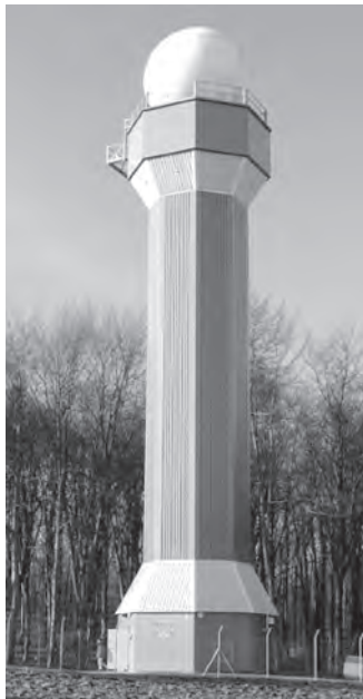
Rys. 12. Radar meteorologiczny w Brzuchani 18)
